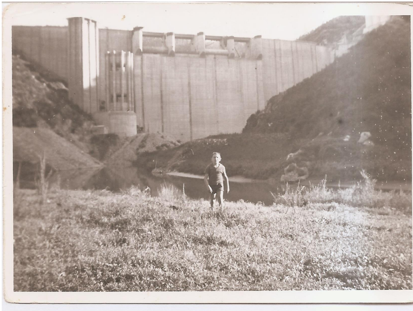
La presa de Sau, vista des d'on avui hi ha l'aigua embassada (1962)
