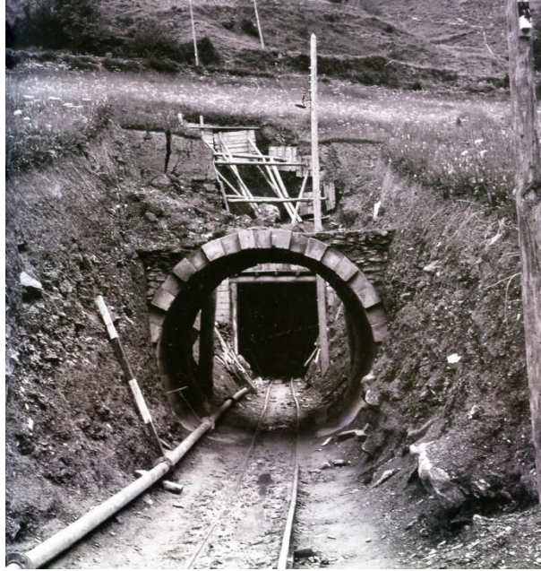
Una ventana d'entrada a la galeria
